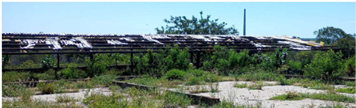
Figura 8 – Platô de secagem natural, vista do telhado.
