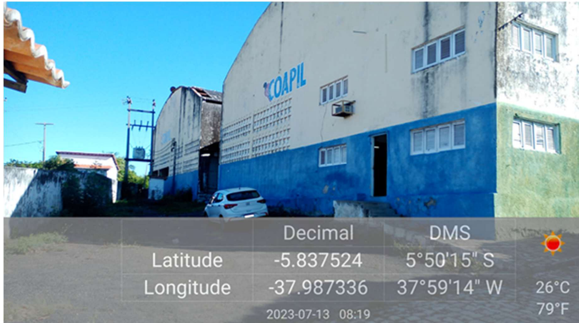
Figura 1 - Fachada do principal galpão na entrada do complexo inativo.
