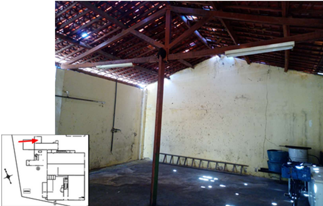
Figura 14 – Galpão coberto anexo.
