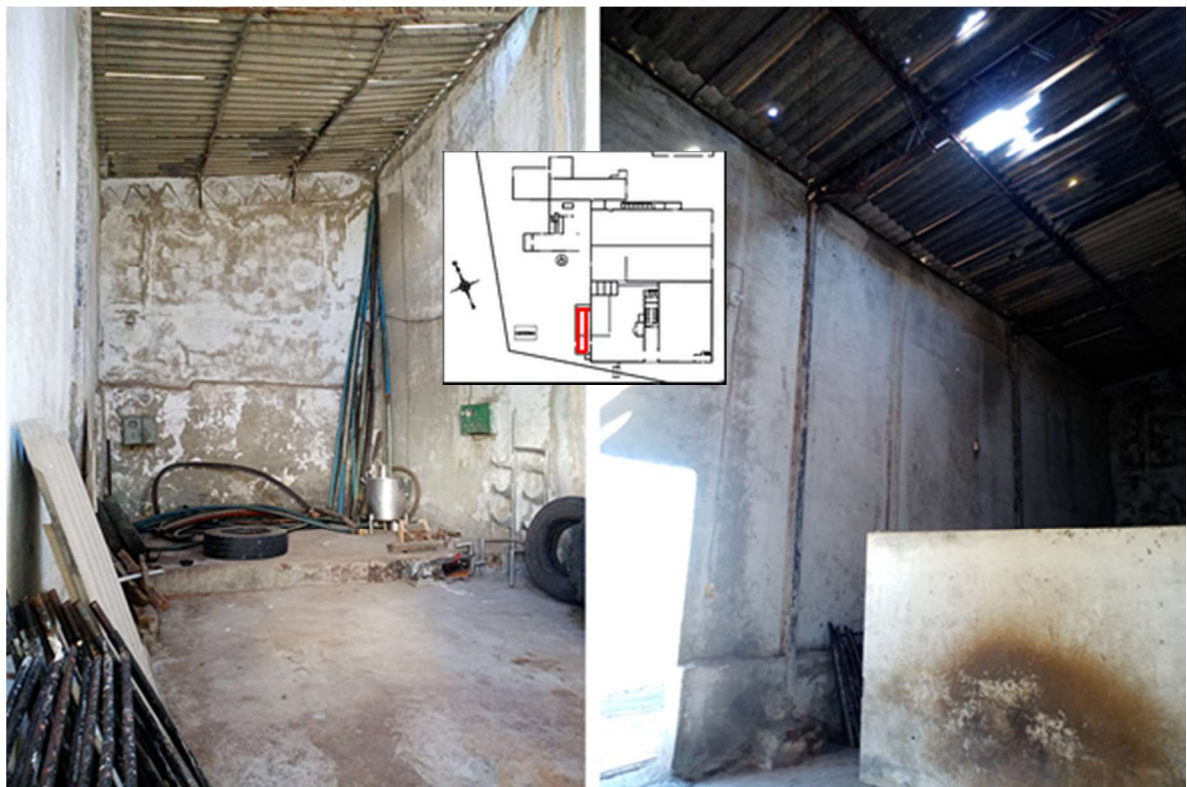
Figura 33 - Interior do galpão.
