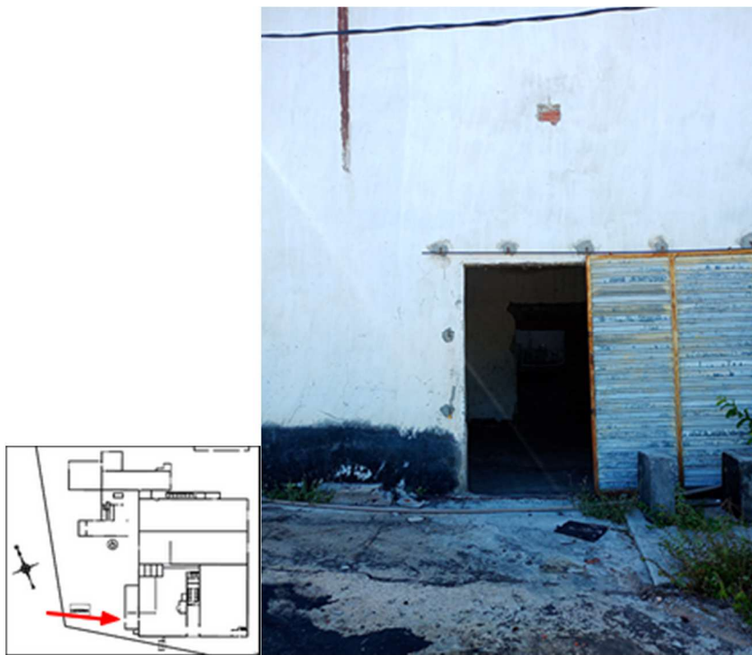
Figura 32 - Acesso ao galpão G.
