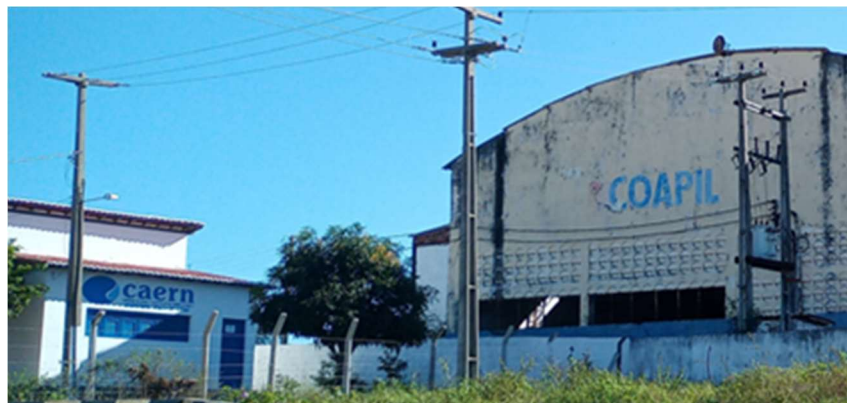
Figura 5 – Estações dedicadas para fornecimento de água CAERN e energia COSERN.
