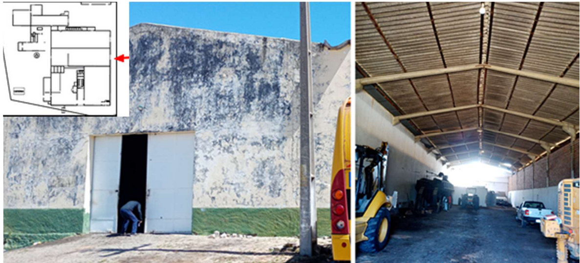
Figura 30 – Acesso frontal e interior do galpão F.
