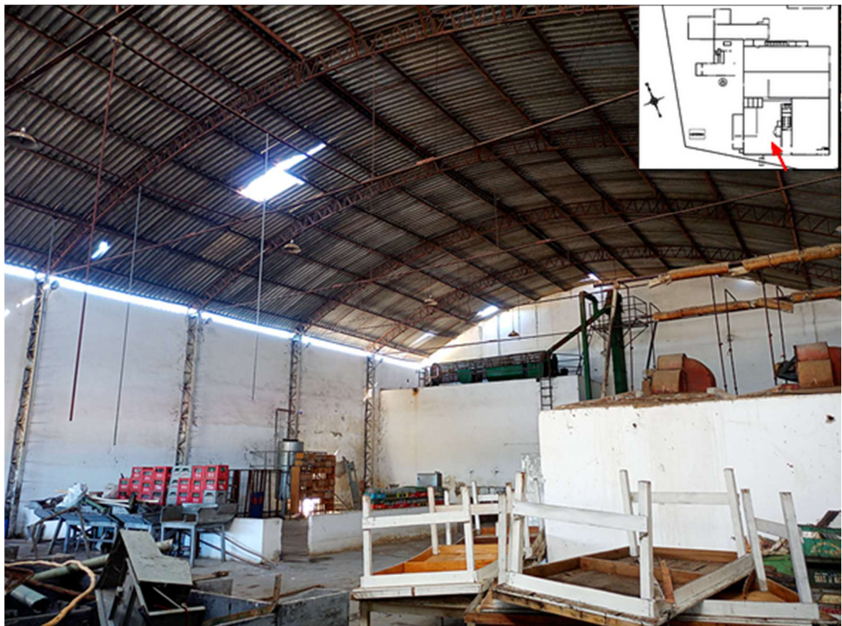
Figura 34 - Galpão H, visão geral.
