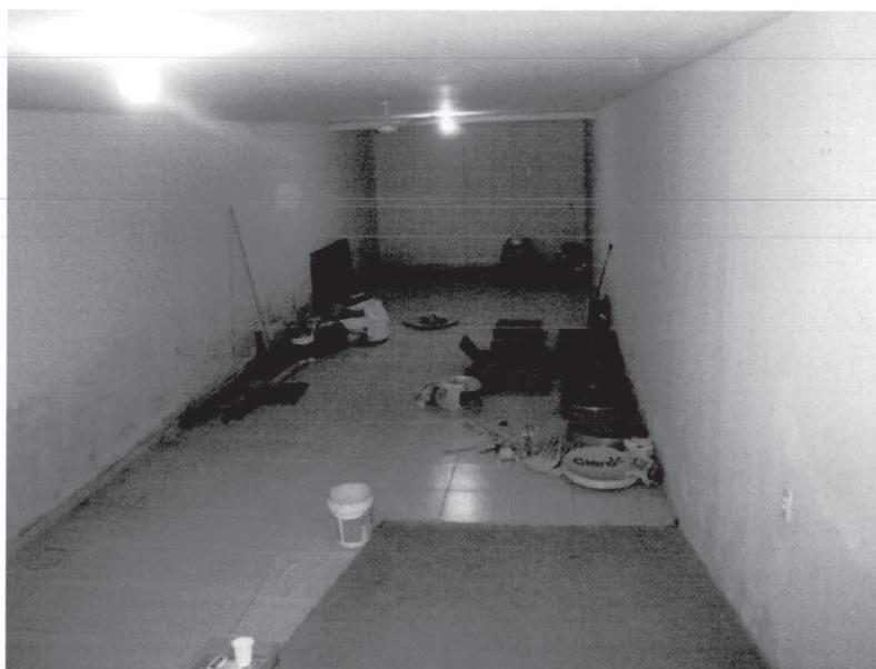
Foto 06 – Rua São João, 18
