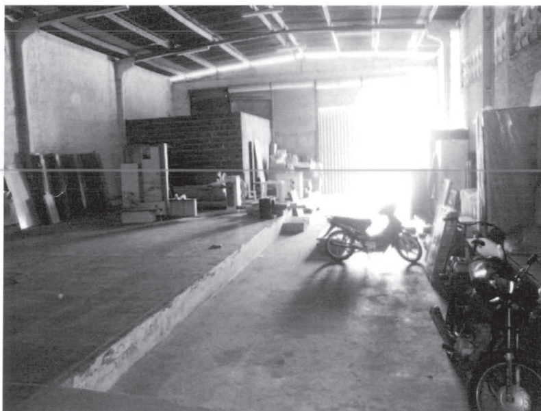
Foto 09 – Rua São João, 18
