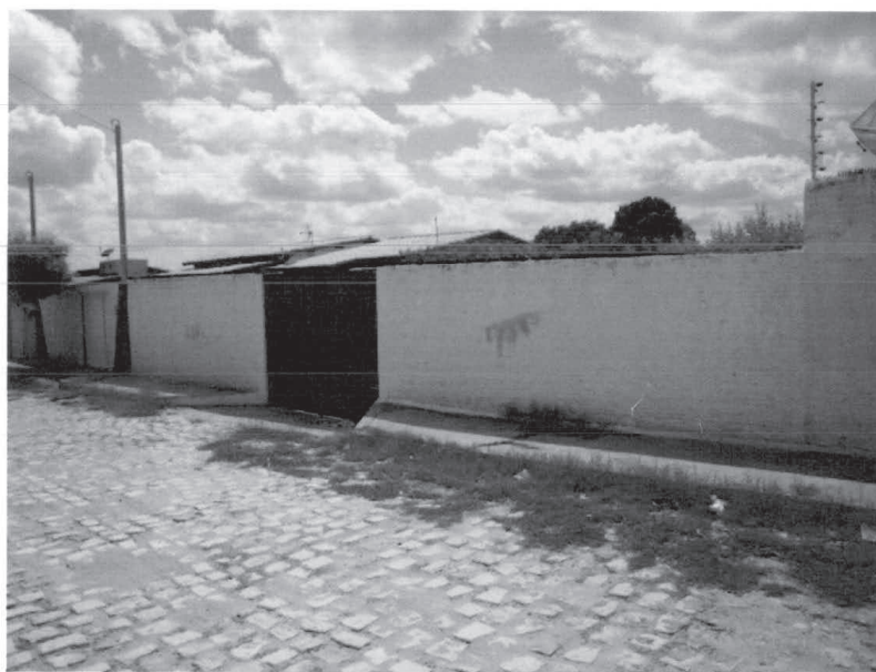
Foto 14 – Loteamento Vista Bela – Quadra 16 – Lote 5
